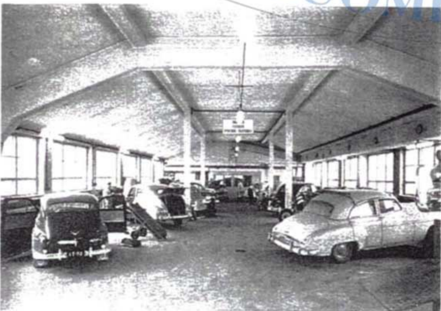
Näkymä uudesta korjaamohallista joka on varsinaisen huoltokorjaamon toisessa kerroksessa.
