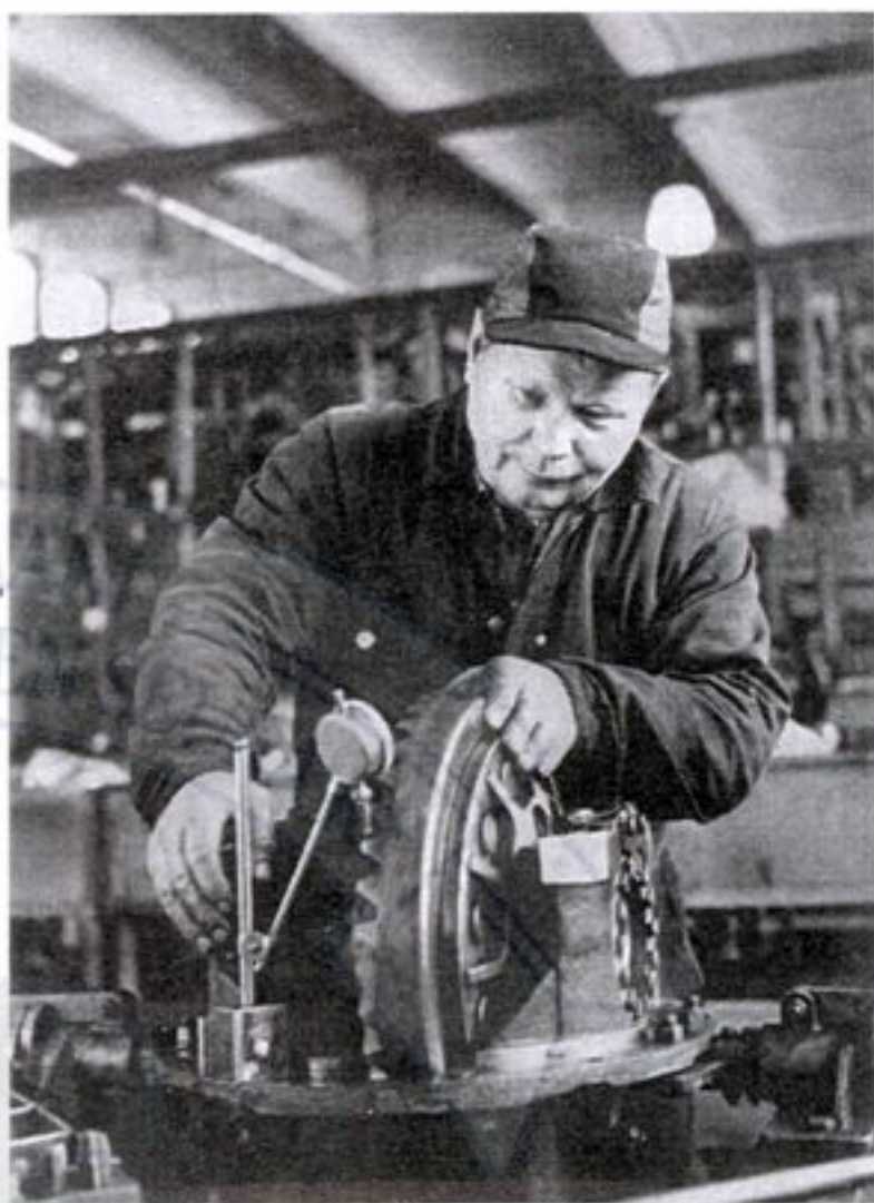
Kuvassamme käynnissä erittäin suurta tarkkuut-ta vaativa vetopyörästön asennus.
