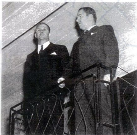
Toim.joht. A. Horkka ja ins. S. O. Salminen keskustelemassa korjaamon parveketasanteella.
