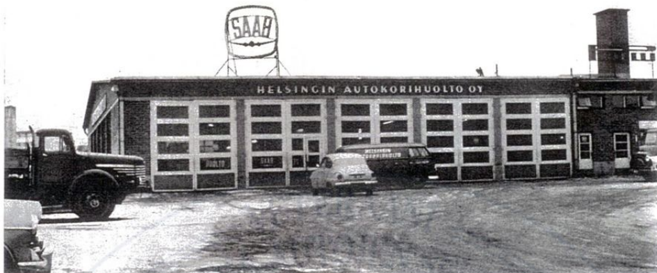
Korjaamorakennuksen julkisivu katsottuna Porin pikatieltä.
