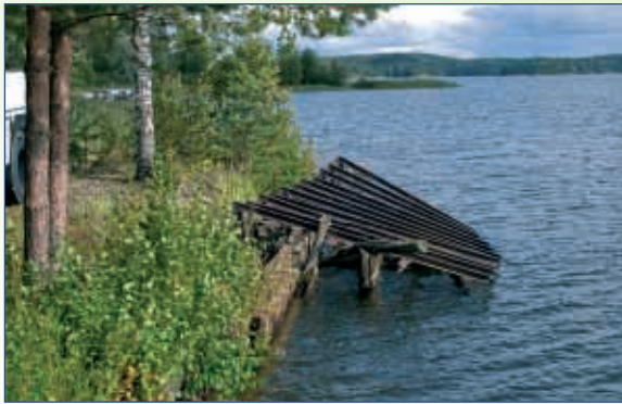
Haverin tilan säilyttämä raudoitettu pudotuspaikka. (AR)
