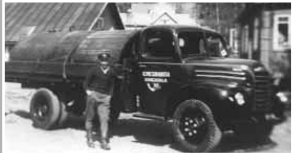
Thames 1952 puisella lipeäkuljetussäiliöllä. Om. kangasalainen Kalervo Mesiranta. Lipeää käytettiin pölyn sitomiseen sorateillä. Puusäiliö kesti lipeän syövyttävää vaikutusta metallia paremmin.
