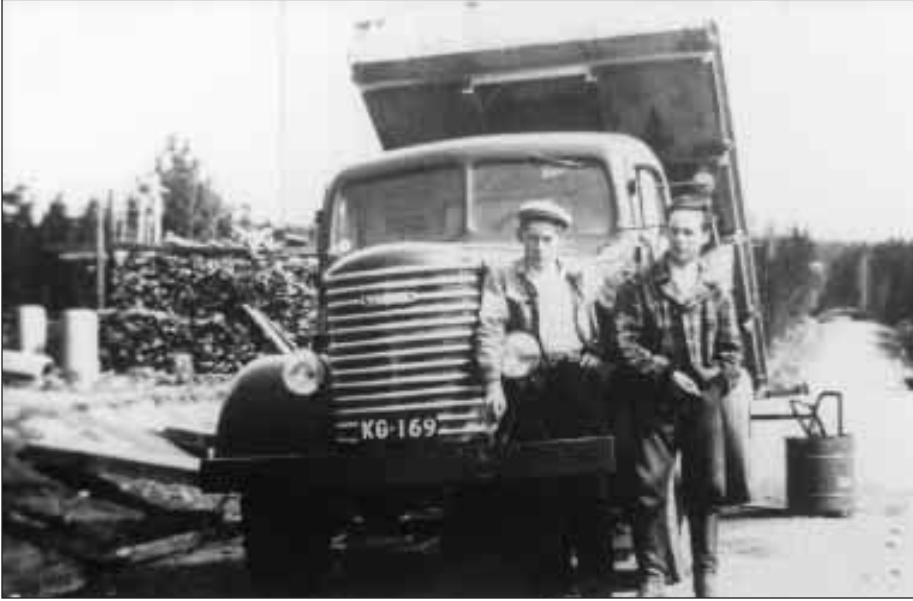
Autoilija Väinö Paldan (oik.) ja apumies Arttu Pekkinen sekä vuonna 1948 valmistunut Vanaja V-48 eli yksi viimeisistä Vanaja-merkin keulaansa saaneista Sisu S-22 -autoista Rautavaaran tietyömaalla syksyllä 1949. Ohjaamona on Valtion lentokonetehtaan (liitettiin vuonna 1950 Valmet Oy:öön) valmistama "Kuoreveden uudempi matala malli".
